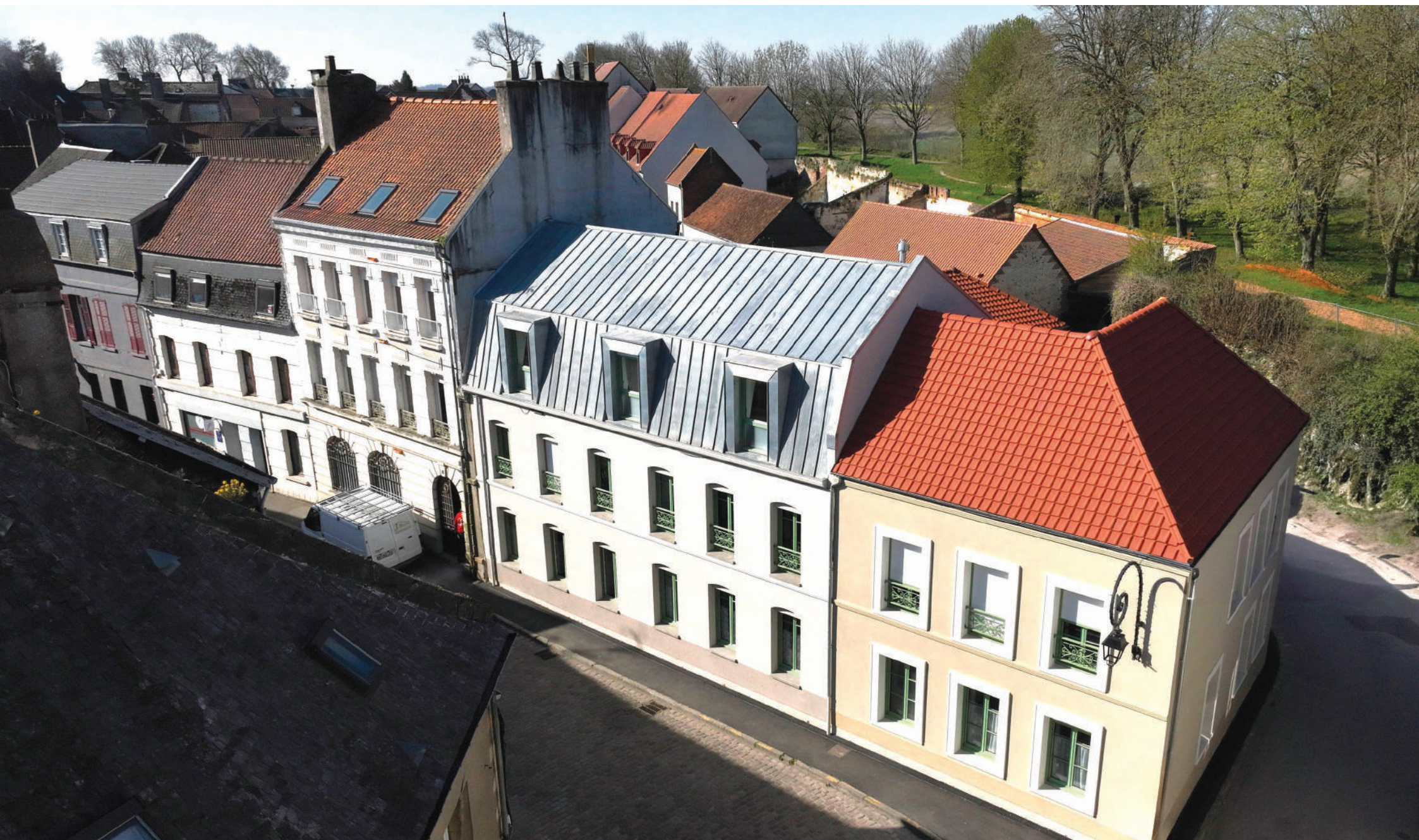
6 logements collectifs - Rue Pierre Ledent - MONTREUIL SUR MER
